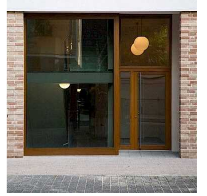
Communal residential entrance Stefan Forster GmbH - Wohnhaus Ostendrade
